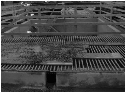
Figura 12 - Tanque de armazenamento de água servida e separação de sólidos em suspensão
