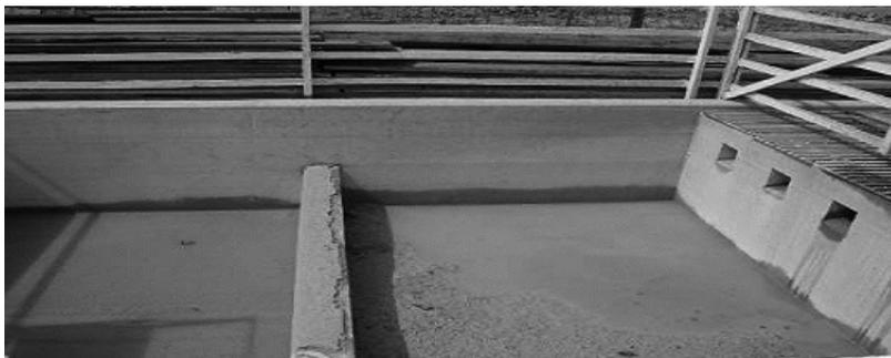
Figura 13- Tanques de captação, decantação e armazenagem
