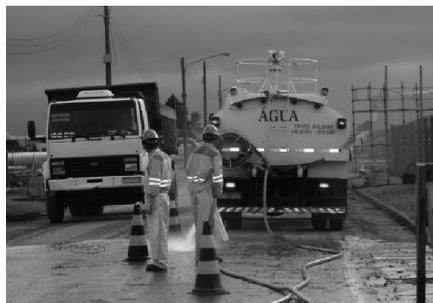
Figura 14 - Limpeza do asfalto com a água de reuso e lavagem de pneus dos veículos na saída do canteiro
